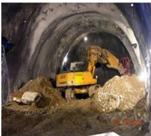
6 Сурет – Liebherr R932 экскаваторы және «Meyco Suprima» машинасы
