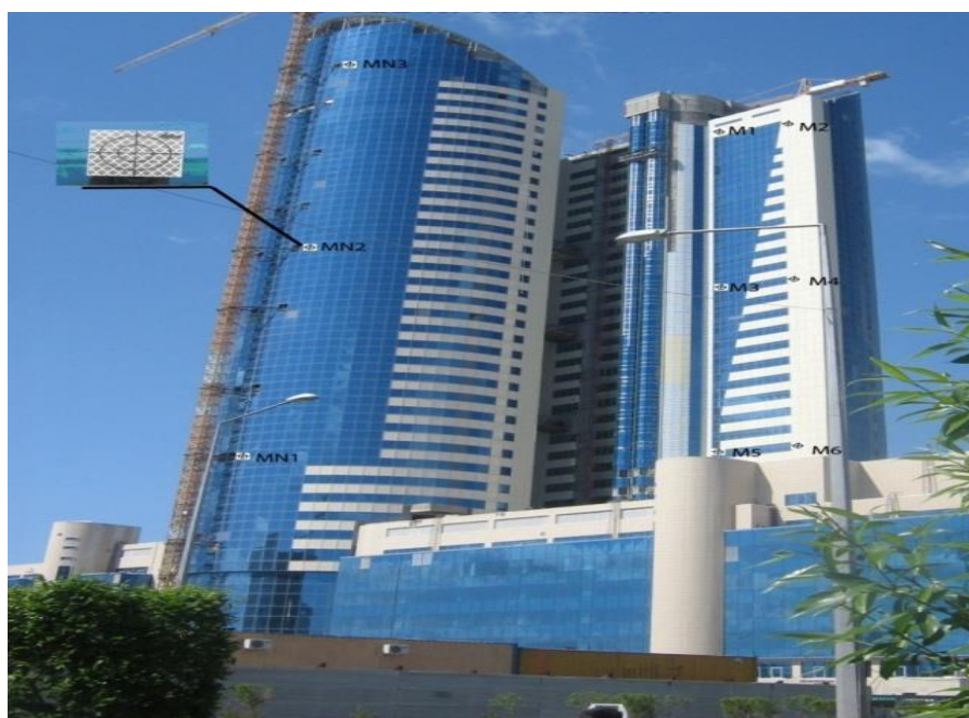
19 Сурет – Ғимараттағы бақылау маркаларының орналасуы
